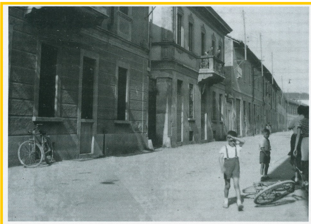
Vecchia foto della caserma in via Carlini
